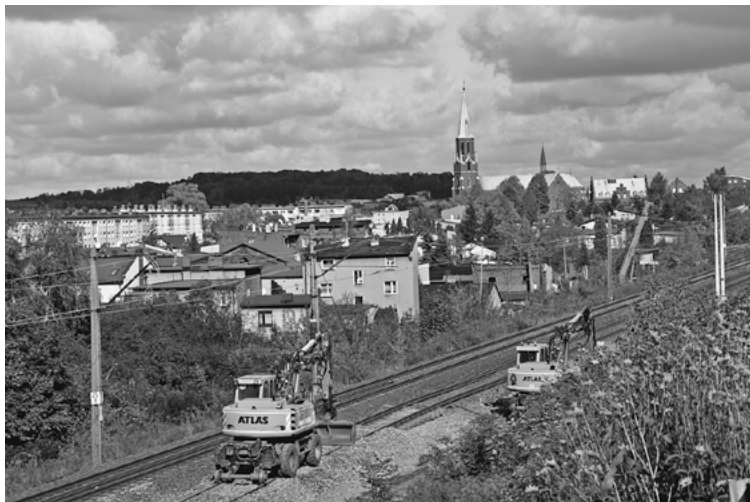
Remont linii kolejowej nr 131.
